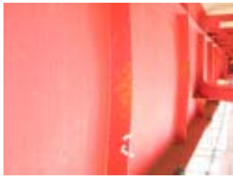
(図-11・写真-2 腹板の腹部ぶくれ)
