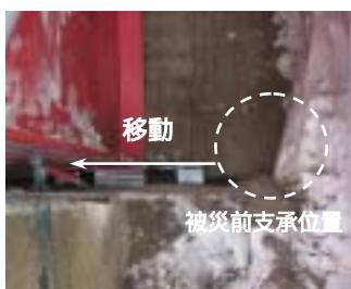
(写真-4 支承の損傷・変位制限装置の変形)
