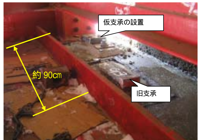
(写真-7 仮支承の設置)
