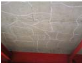
(図-11・写真-2 腹板の腹部ぶくれ)
