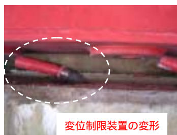
(写真-4 支承の損傷・変位制限装置の変形)
