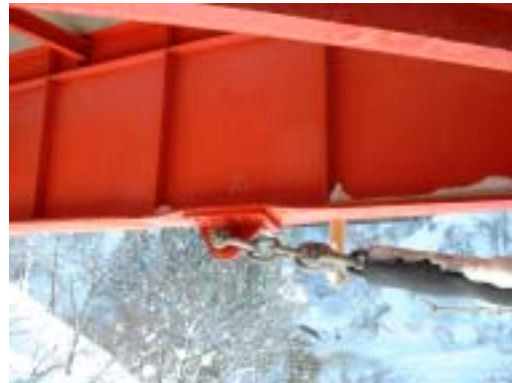
(写真-6 主桁の変形)
