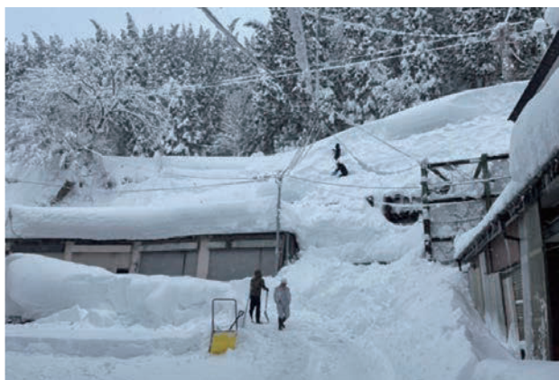
【山形県】大蔵村 (人力による道路雪庇除去作業)
