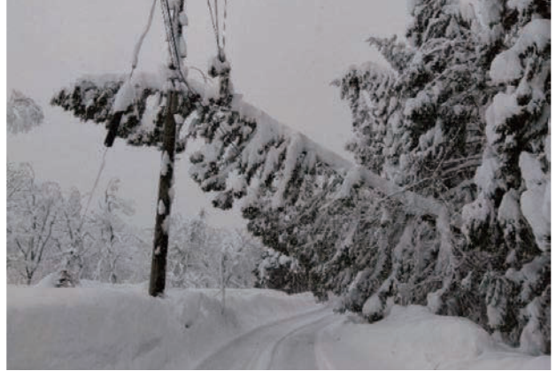
【山形県】小国町 (倒木による交通障害)
