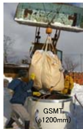
写真 3 GSMT への初期充填の際の投雪方法
