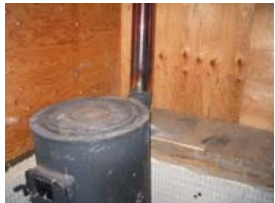
図-6 レンガ内張り、とろ火連続燃焼、薪ストーブ
