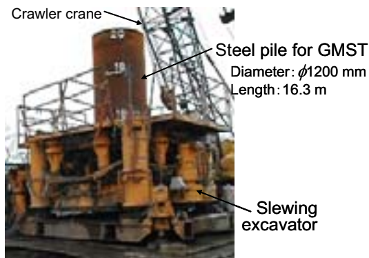
写真 1 全旋回回転圧入機による鋼管杭の埋設
