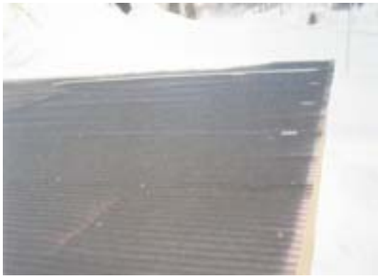
図-25 垂木ダクト煙突の作動実験 2/13/12:00 経過 48:00 h
