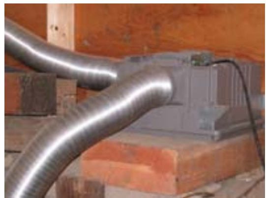
図-8 中間ダクトファン
