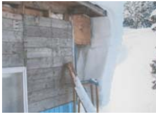
図-26 垂木ダクト煙突の作動実験 切れずに伸びていった屋根雪
