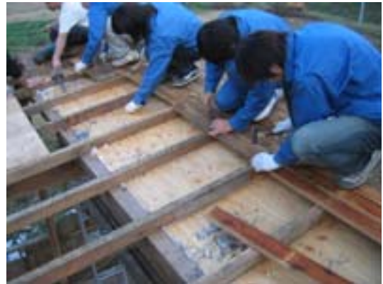
図-4 野地板張り
