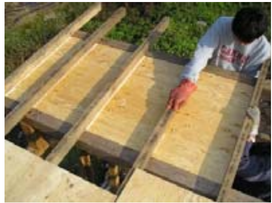
図-2 垂木ダクト底板張り作業
