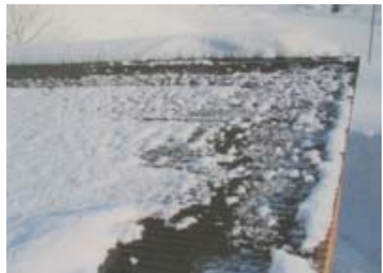
図-24 垂木ダクト煙突の作動実験 2/13/8:00 経過 44:00 h
