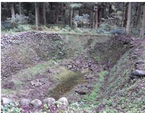
図 13 南東側壁面の地震による崩落
