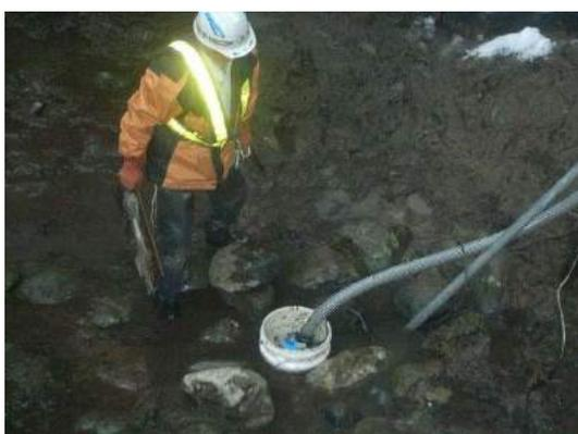
図 15 排水用水中ポンプの設置
