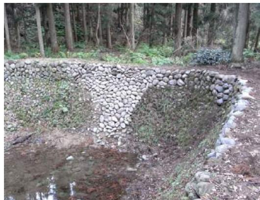
図 14 石積み補修後の南東側壁面
