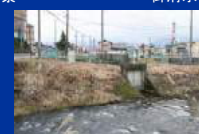
河川水消雪パイプ
