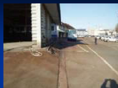
車両が入れなくなった車庫
