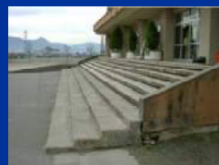
縦ぎ足された階段
