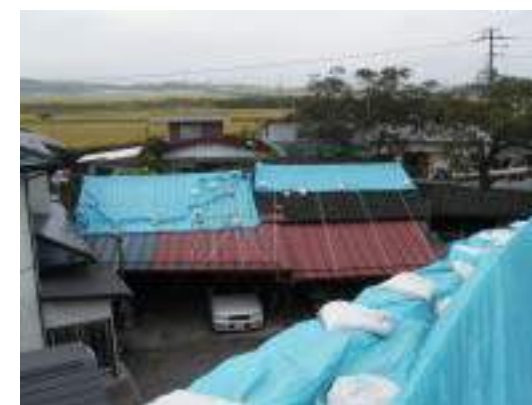
地震で屋根が倒壊した家屋
