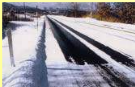
塩化ナトリウム混合アスファルト
