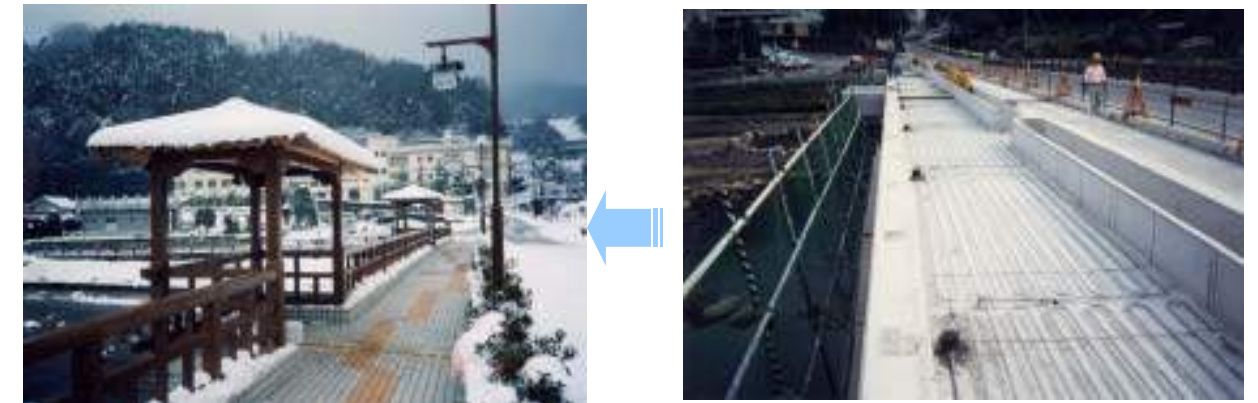
図56 温泉熱を利用した消融雪施設(鳥取県)
