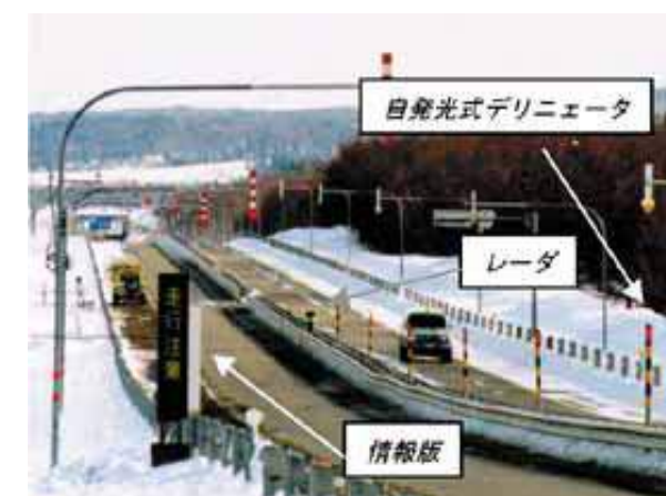
図5.4 インテリジェントデリニュータシステム
