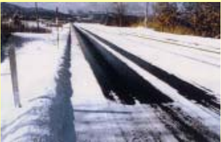
塩化ナトリウム混合アスファルト
