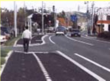
廃材ゴムチップを利用した弾性舗装
