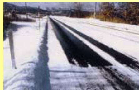
塩化ナトリウム混合アスファルト
