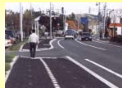
廃材「ゴムチャップ」を利用した弾性舗装
