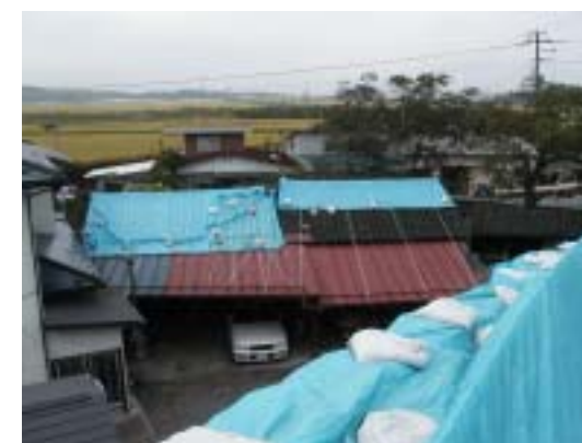
地震で屋根が倒壊した家屋
