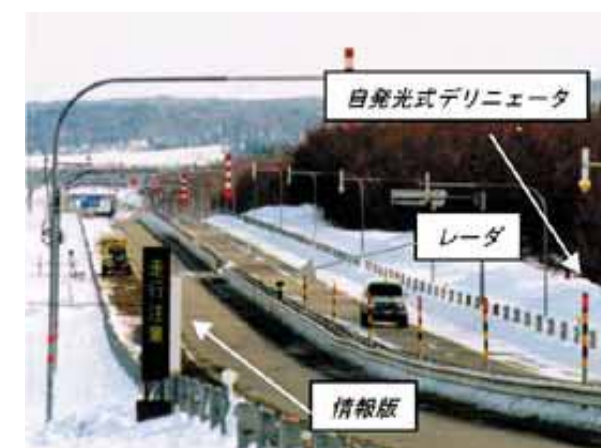
図5.4 インテリジェントデリニエータシステム
